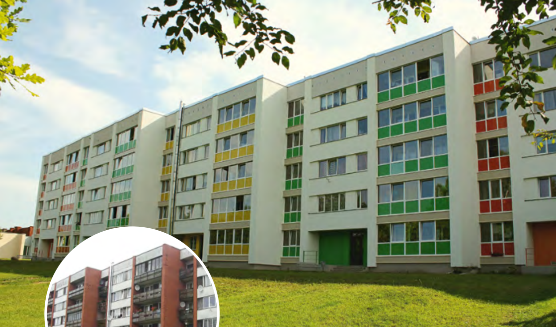
Ēkas visaptverošas atjaunošanas piemērs (pirms un pēc). Panāktais enerģijas ietaupījums ir vairāk nekā 55%
